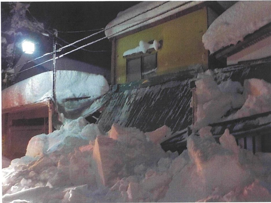
雪の重みによるアーケード倒壊（長岡市）
